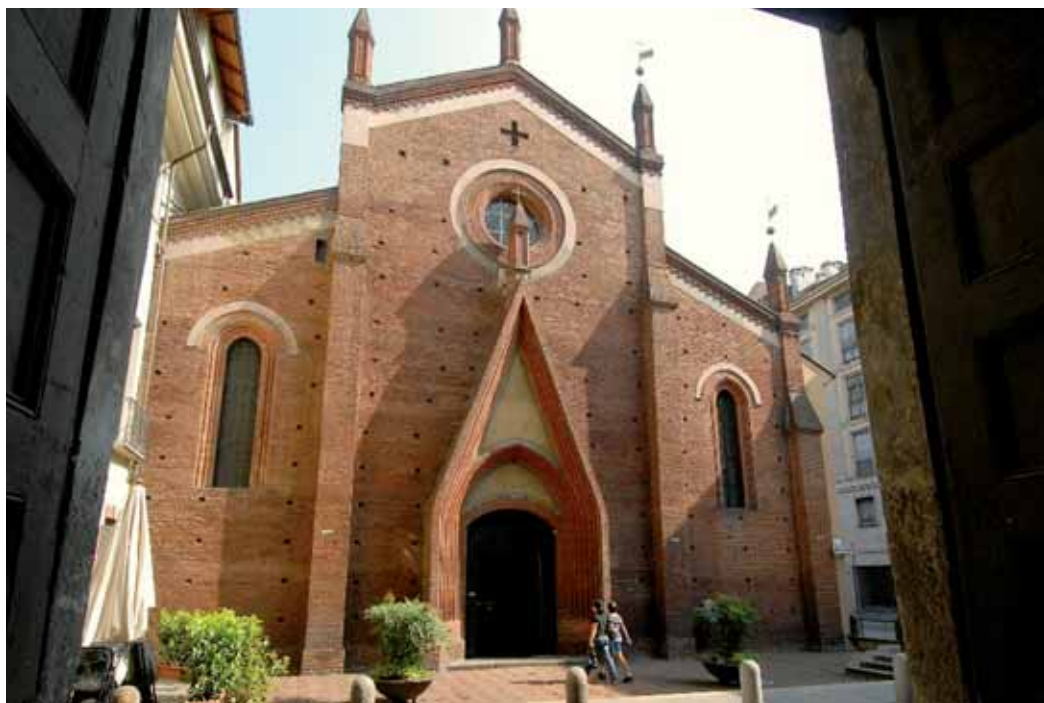
Facciata della chiesa di S. Domenico in Torino
